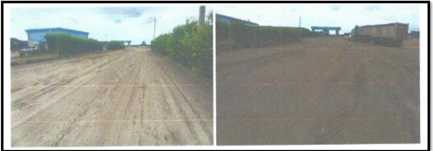
Imagen No. 4 – Zona de básculas- PUERTO BRISA
