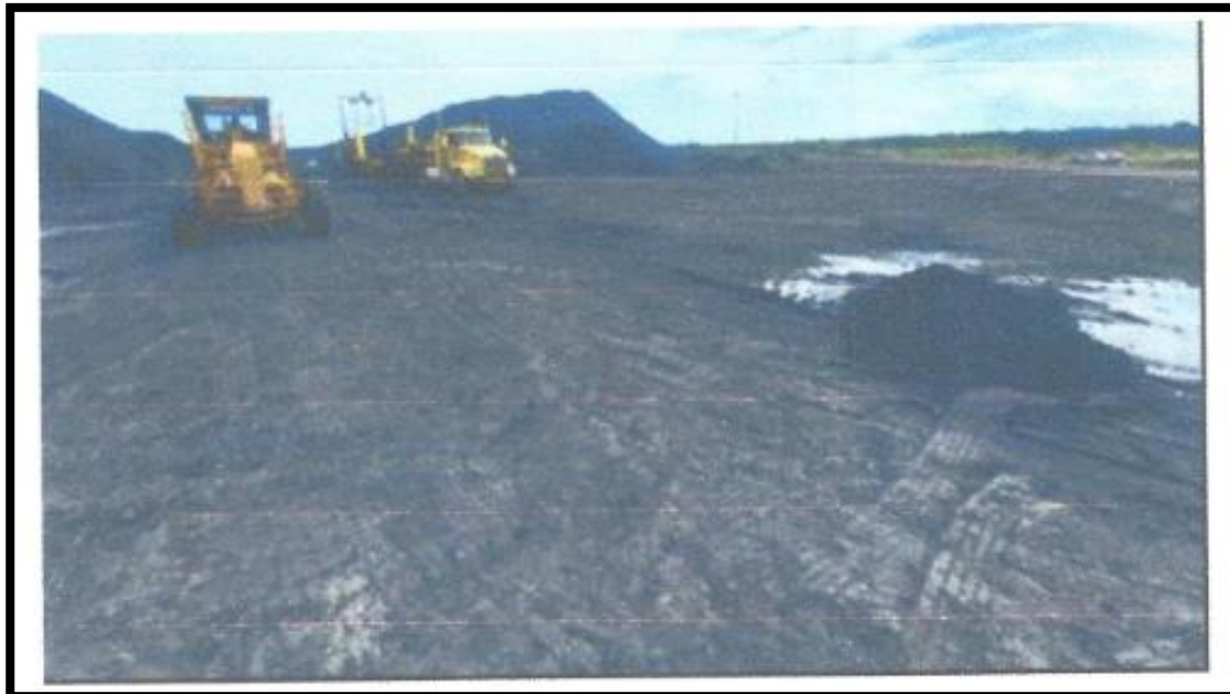
Imagen No. 5 –Zona de descargue – PUERTO BRISA
